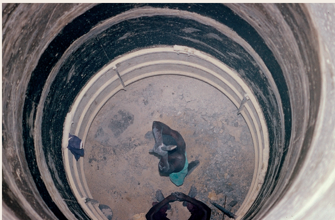
Fonçage, à la barre à mine, au puits de Chin Fangalan. Niger (2005).
