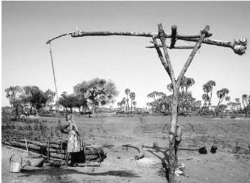
Figure 2. Un puits à balancier à proximité du lac Tchad (Ph: Picasa, années 1990).
